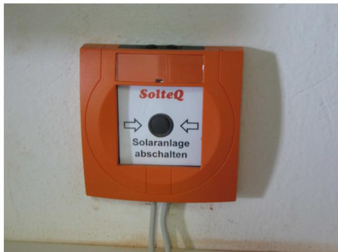
Figura 4-6: sistema di limitazione delle tensioni tramite cortocircuitazione del singolo pannello. Comando a distanza
