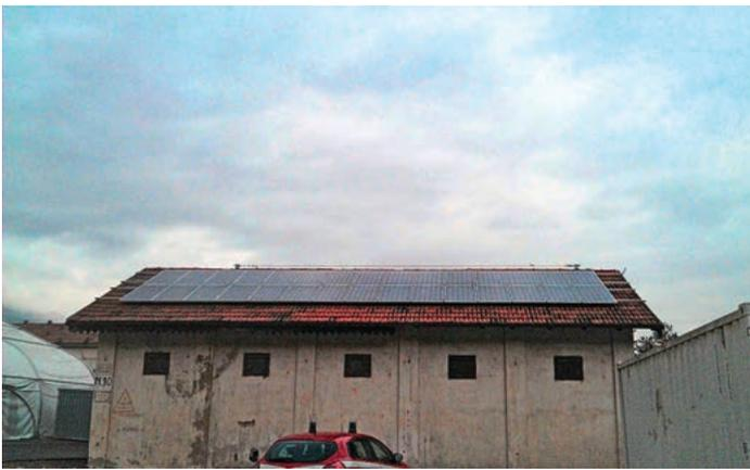
**PROVE CON BASSA LUMINOSITÀ.** Il test compiuto in una giornata nuvolosa, con una debole pioggia, ha rilevato la presenza di una tensione di circuito aperto elevata, pari a circa 590 Volt, che potrebbe rivelarsi pericolosa per l'uomo. Chiudendo invece il circuito con il reostato, il rischio si potrebbe ridurre a contrazioni muscolari involontarie, senza effetti fisiologici permanenti, comunque non esenti da conseguenze per chi stia operando in copertura.
