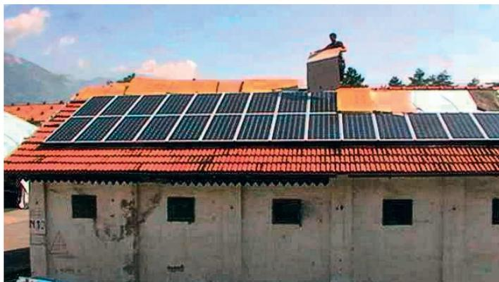
**PROVE DIURNE CON COPERTURA DEI PANNELLI MEDIANTE MATERIALI OPACHI.** Si è provato a schermare i pannelli con cartoni: oltre alla pericolosità dell'intervento, considerando la combustibilità del materiale, si sono ottenuti scarsissimi risultati dal punto di vista del calo delle tensioni.
